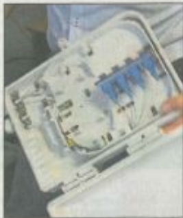
Wasserdichte Glasfaserkabelboxen wurden in Brasilien von den Verdenern eingebaut.
